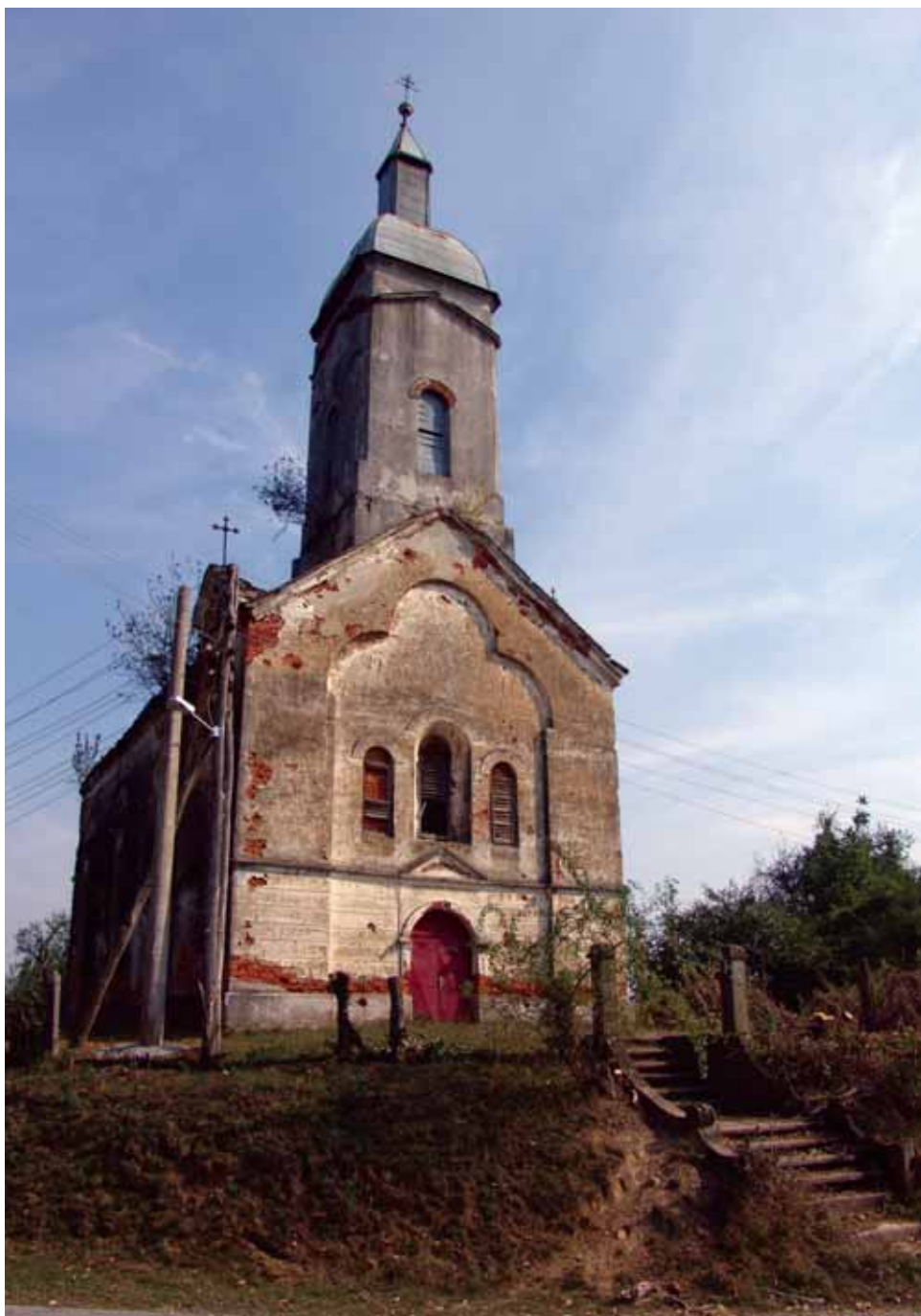
Crkva Svete Petke u Velikoj Peratovici, podignuta 1895. godine na temeljima starije drvene crkve iz 1790. Stradala u ratu (1941–1945). Poslije Drugog svetskog rata obnovljena. Crkva demolirana, ikonostas uništen i sva stakla na prozorima polupana (1991–1993).
