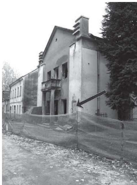
Balkon na zgradi Sportskog društva Sokol („Sokolana”) sa kojeg su 4/5. avgust 1941. godine nesretnici, rasporenihi trbuha bacani na drljače. (Strelica pokazuje mjesto na kome je do 1991. godine stajala spomen-ploča)
